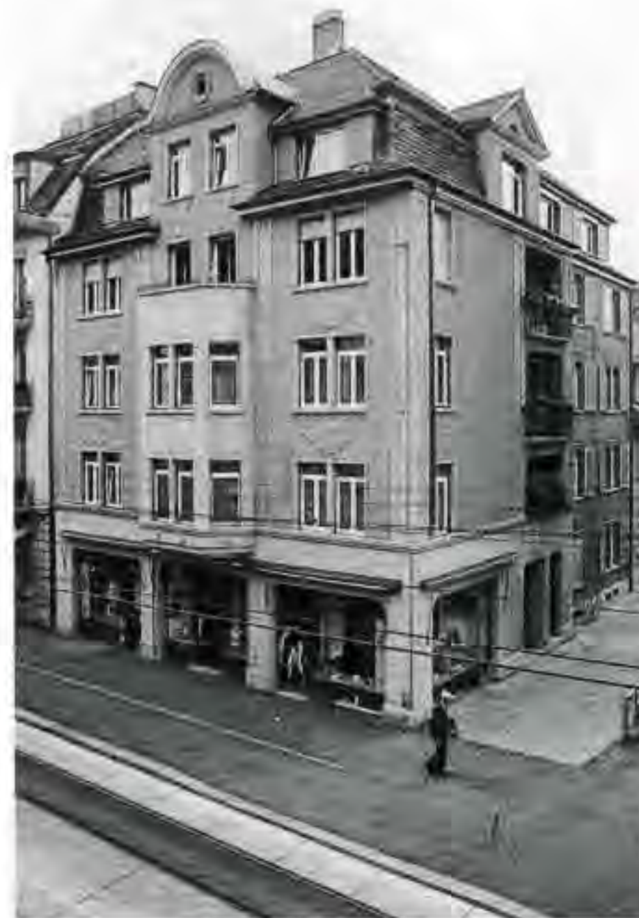
Sanierung Seefeldstrasse, Zürich, 1999
