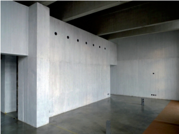
Das rohe Betontragwerk
